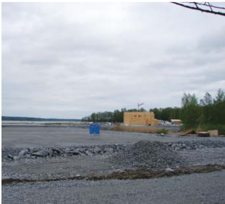
Väggarna på Honkarakennes hus är resta
